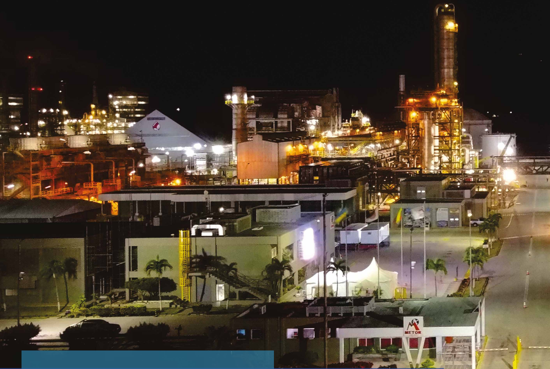
Planta de Metor en el Complejo Petroquímico G/D José Antonio Anzoátegui, estado Anzoátegui. Metor plant in the M/G José Antonio Anzoátegui Petrochemical Complex, Anzoátegui state.
