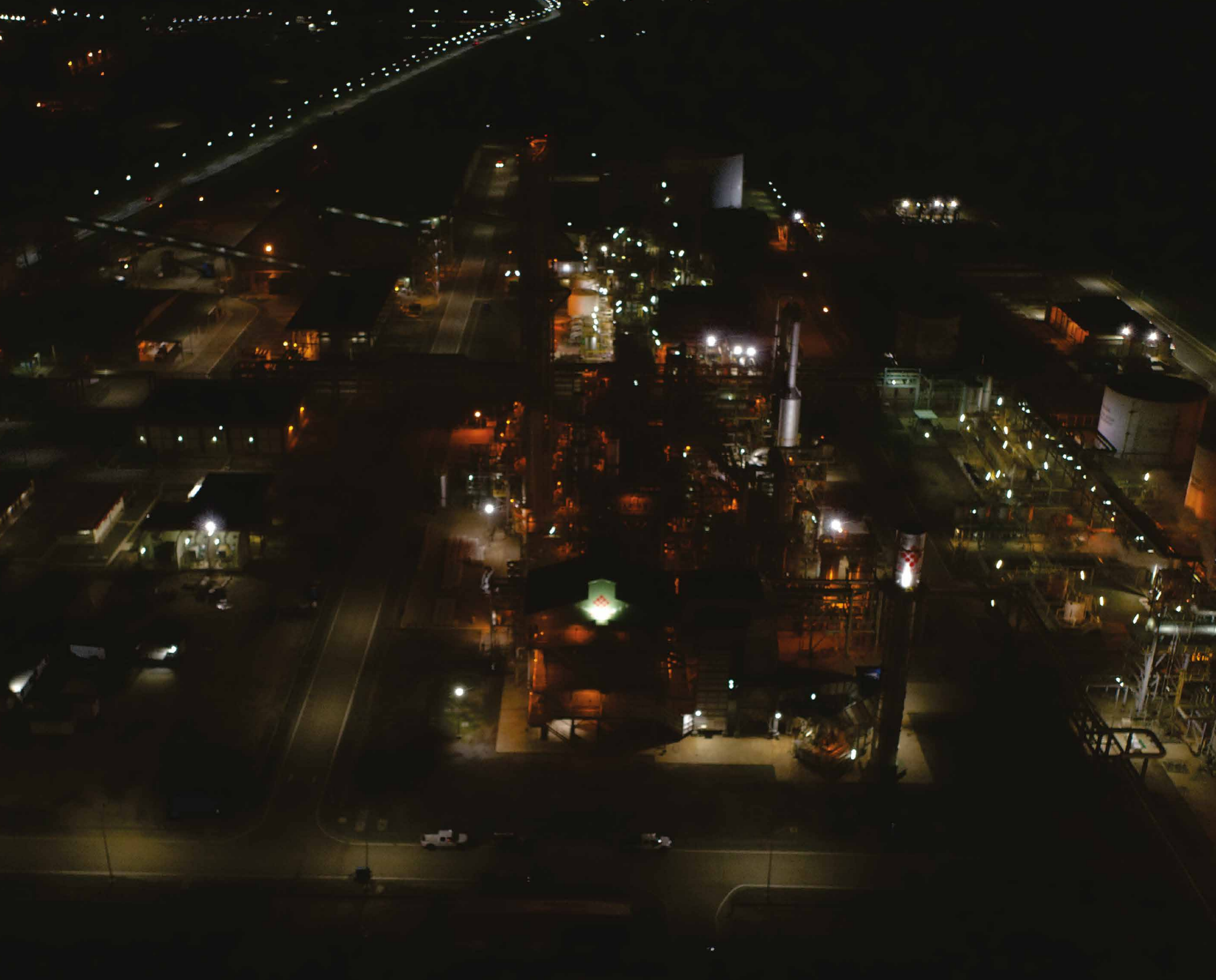
Planta de Nitrógenados del Complejo Petroquímico Hugo Chávez, estado Carabobo. Nitrogen Plant of the Hugo Chávez Petrochemical Complex, Carabobo state.
